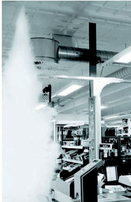
Koordiniert mit der Alarmanlage, setzt die Nebelkanone einen Raum in 12 Sekunden unter Schutznebel.
