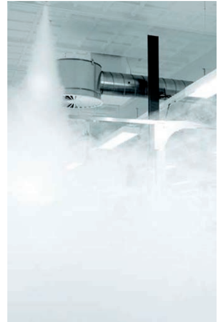
Koordiniert mit der Alarmanlage, setzt die Nebelkanone einen Raum in 12 Sekunden unter Schutznebel.
